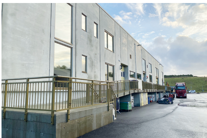
Langs baksiden av betongbygget er det lagt til rette med porter og lasteramper
